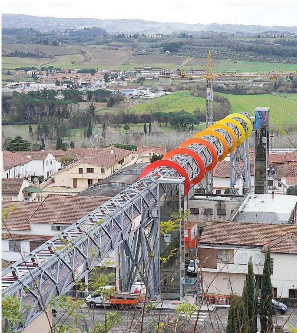
La passerella artistica costruita recentemente a Peccioli
