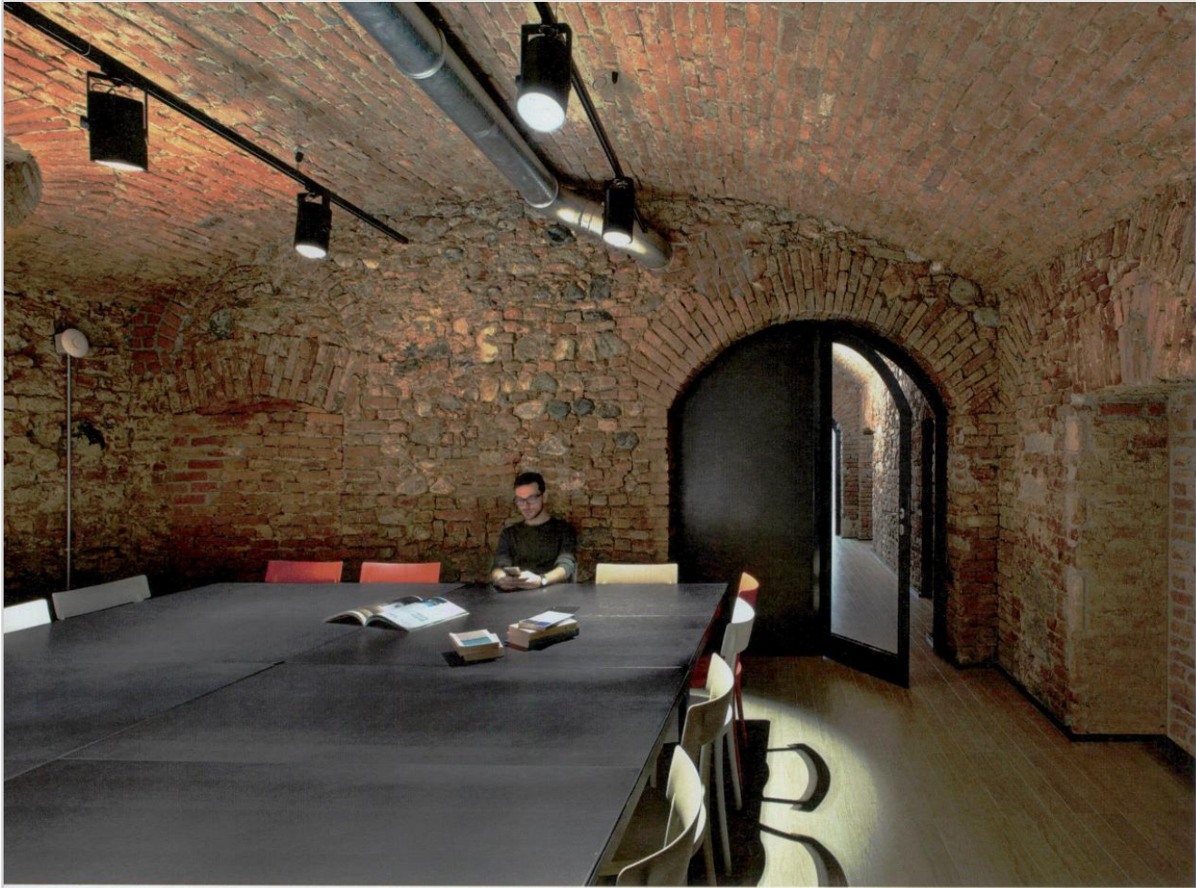
L'intervento di recupero dell'edificio ottocentesco ha previsto il restauro delle facciate e la completa trasformazione degli interni, che sono stati riportati all'impianto strutturale originario.
