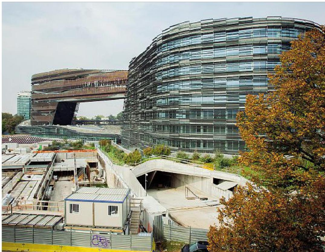
Le forme Il maxi-cantiere del nuovo centro direzionale dell'Eni a Metanopoli progettato da Morphosis e Nemesi con il ponte da 85 metri (foto Yunus Boiocchi/Lapresse)
